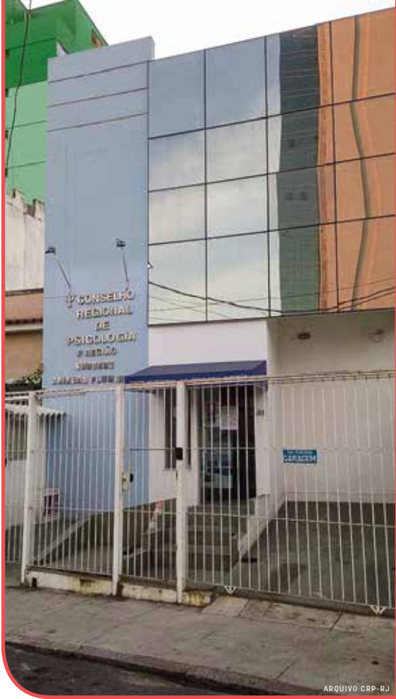
Fachada reformada da Subsede de Nova Iguaçu
